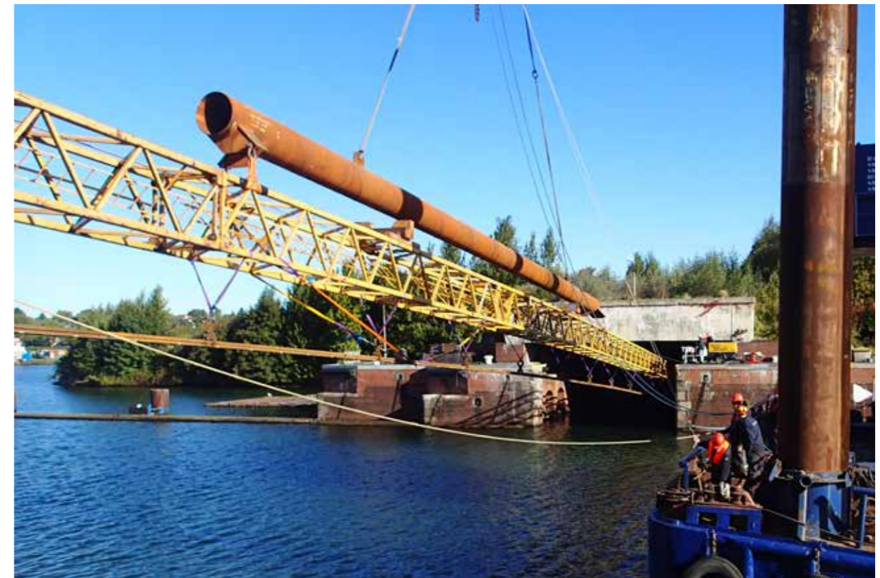
Schienenwechsel in den großen Kammern Kiel-Holtenau
