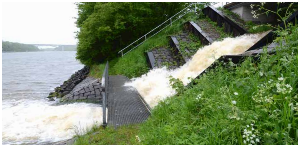
Entwässerungssiel bei Projensdorf
