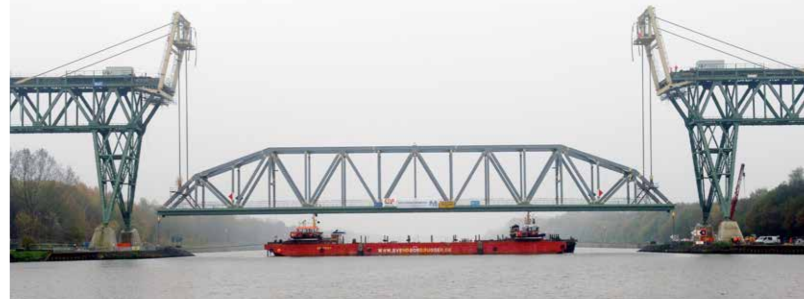
Einsatz des Mittelteils der Eisenbahnhochbrücke, Hochdonn
