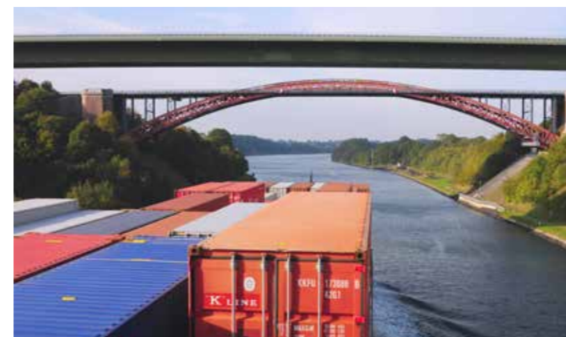
Durchfahrt Levensauer Hochbrücken.
