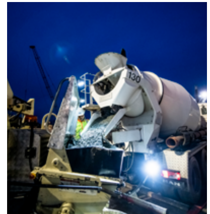
Die Betonage der Kammersohle im Binnenhaupt dauerte über 40 Stunden.
