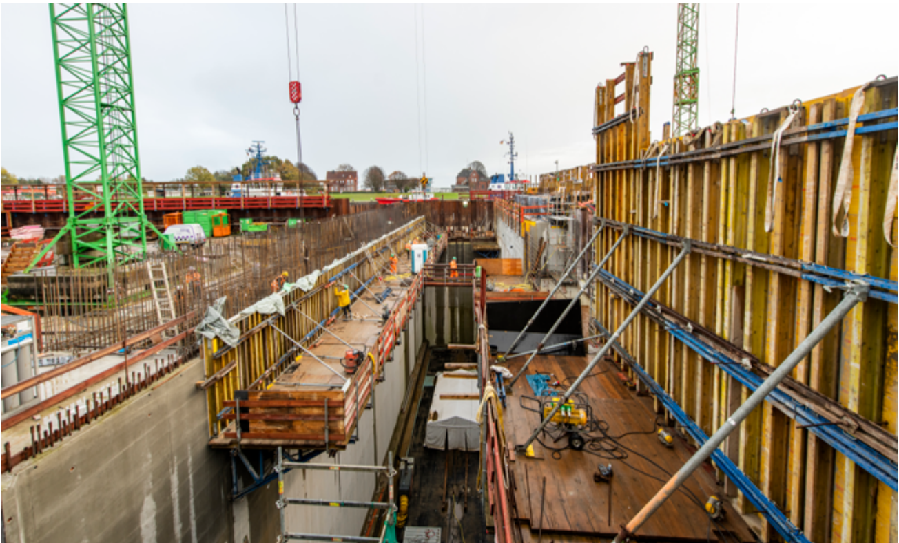
Mit einer Höhe von plus 6,50 Meter Normalhöhennull übernehmen die elbseitigen Torkammerwände im Außenhaupt den Hochwasserschutz.
