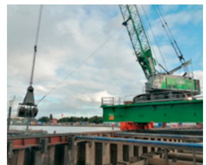
Aushubarbeiten in der Drempeibaugrube des Binnenhauptes.
