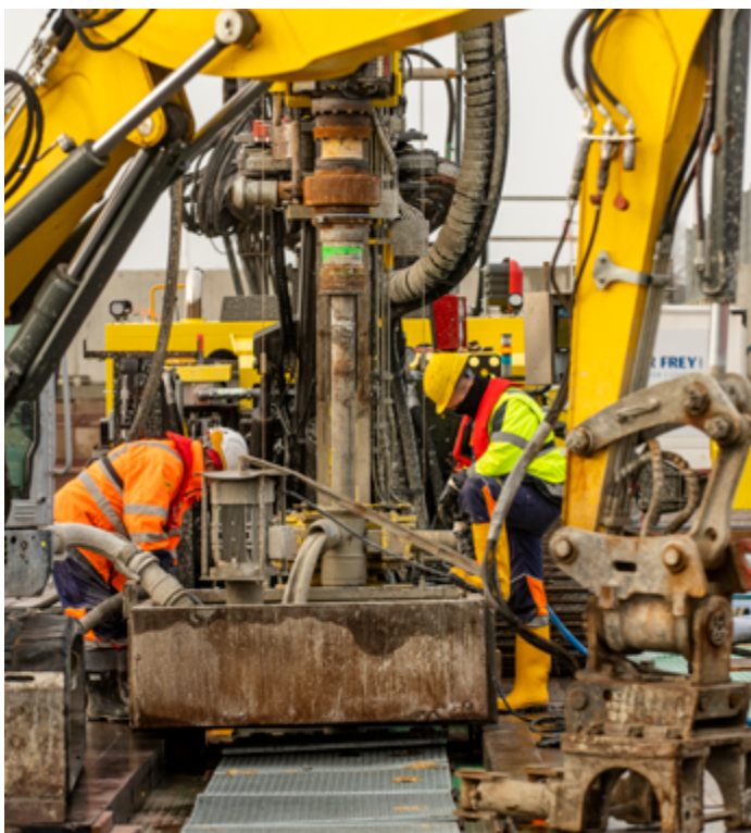
200 Düsenstrahl-Auftriebspfähle sind bereits fertig.
