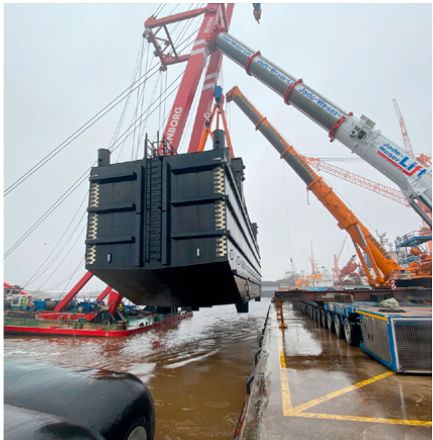
Im November wurde ein fertiggestellter Hebeponton für Krängungstests ins Wasser gelassen.
