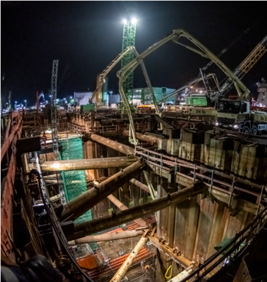
Die Betonage der Kammersohle im Binnenhaupt dauerte über 40 Stunden.
