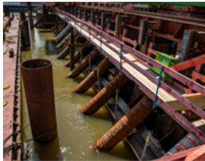
Wochen insgesamt zwanzig jeweils rund 50 Meter lange Schräganker in Winkeln von 43 bis 47 Grad entlang der kanalseitigen Spundwand der Drempel-Baugrube in den Grund des Nord-Ostsee-Kanals gerammt wurden. Durch die leichte Varianz der Rammwinkel verteilt sich die Last der Verankerung auf ein größeres Bodenareal und gewährleistet damit
