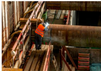
Sämtliche Steifen werden an beiden Enden mit Schweißbrennern durchtrennt und anschließend einzeln per Kran aus der Baugrube gehoben.
