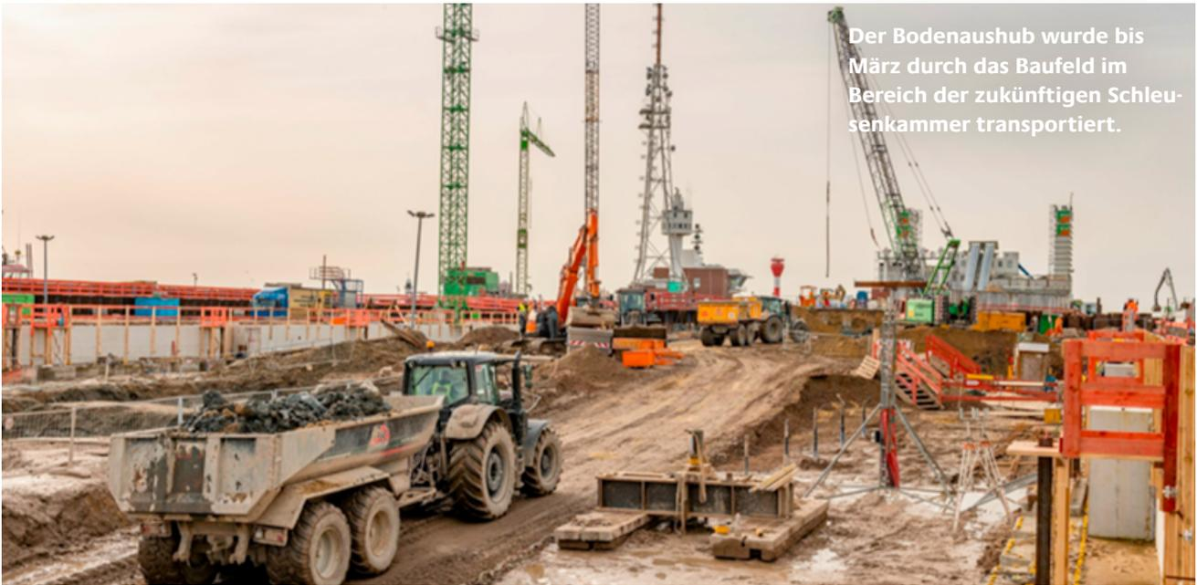
Der Bodenaushub wurde bis März durch das Baufeld im Bereich der zukünftigen Schleusenkammer transportiert.
