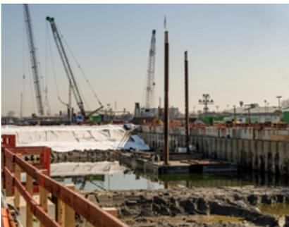
Im Bereich der nördlichen Kammerwand wurde die letzte von insgesamt 34 großen Abschirmplatten entlang der Schleusenkammer fertiggestellt. Sämtliche Abschirmplatten sind auf Bohrpfählen gegründet und tragen später das SchluSENDeck samt Pollern und vorgesetzter Betonschürze. Auf die fertiggestellte letzte Platte an der nördlichen Kammerwand wurde Sand aufgeschüttet, über den ein Teil der neuen Baustraße verläuft.
