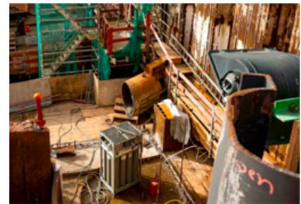
Der Wasserdruck der benachbarten Drempeibaugrube lastet jetzt auf der Trennwand und wird (über die viereckige Stütze unmittelbar neben der durchtrennten Steife) von dem bereits erstellten Massivbau aufgenommen.
