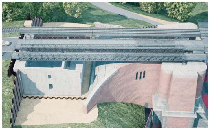
Visualisierung: Bau des nördlichen Widerlagers
