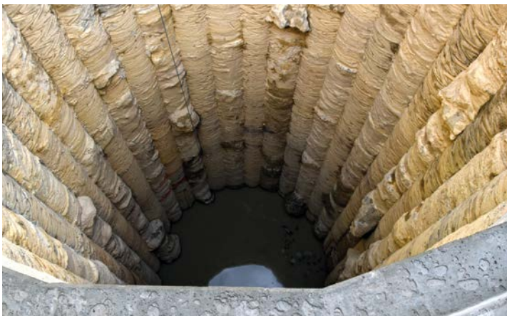
Blick in einen der rund 30 Meter tiefen Bohrfahlringe für die Gründung der neuen Brückenbögen
