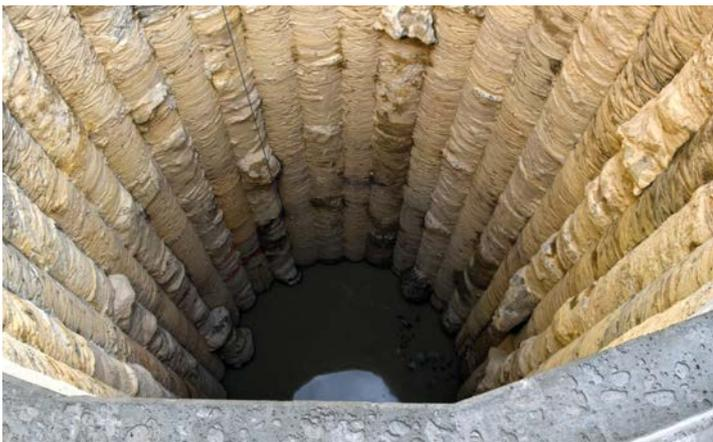
Blick in einen der rund 30 Meter tiefen Bohrfahlringe für die Gründung der neuen Brückenbögen
