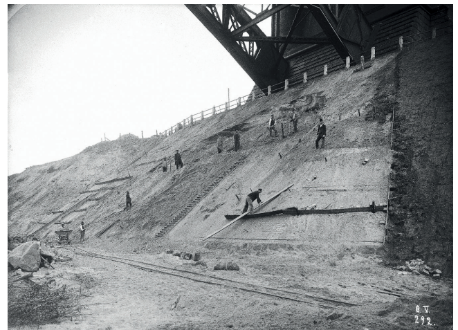
Bild 4. Abgrabung der Böschung vor dem Brückenwiderlager im Jahr 1914 Foto: [1] Fig. 4. Reconstruction of the embankment slope in front of the bridge abutment in 1914 Source: [1]
