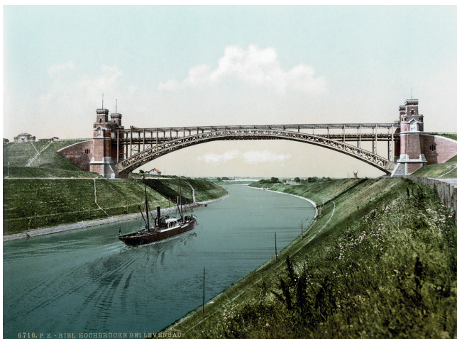
Bild 2. Ursprüngliche Brücke nach der Fertigstellung 1895 Foto: Postkarte Fig. 2. Original bridge after completion in 1895 Source: postcard
