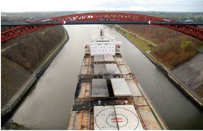
Bild 8. Schiffspassage der Engstelle Levensau mit Frachter Verkehrsgruppe VG 5 ( l = 200\text{ m} , b = 25\text{ m} , max. Tiefgang = 9,50\text{ m} ); Schiffgröße NOKmax = VG 6 ( l = 235\text{ m} , b = 32,50\text{ m} , Tiefgang beschränkt); Breite der Fahrrinne 44\text{ m} (Foto: Behling) Fig. 8. Passage of a ship l = 235\text{ m} , b = 32.50\text{ m} through the bottleneck; the width of the canal is 44\text{ m}
