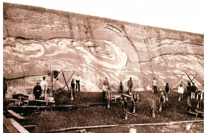
Bild 19. Deutlich erkennbare heterogene eiszeitlich geprägte Geschiebeböden im Bereich der Hochbrücke Levensau um 1890 (Bild: WSA) Fig. 19. Ice-age ground formation beneath the Levensau Bridge, photo 1890
