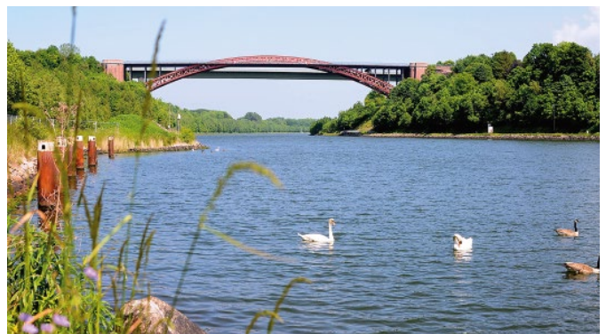
Bild 6. Hochbrücke Levensau nach Umbau 1955 – heute; Rückbau der Turmaufbauten, Fahrbahnverbreiterung (Foto: WSV) Fig. 6. Levensau Bridge after the 1955 bridge modification to the present day
