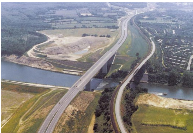
Bild 10. 1. und 2. Hochbrücke Levensau im Luftbild (1986); Seitenentnahmen für Dammbauwerke HbLev 2 links oberhalb und unterhalb des Kanals; rechts oben allgemeines Wohngebiet Kiel Suchsdorf (Foto: LBV-SH)
