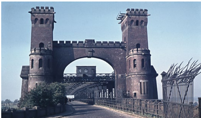
Bild 4. Hochbrücke Levensau; Bauzustand 1894 (Foto: WSV) Fig. 4. Levensau Bridge in state of construction in 1894
