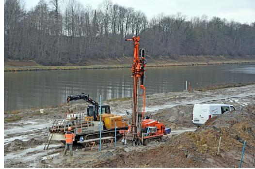
*Einbau der Drainagesäulen mittels Aushubverfahren (Bild links) und Einbau von Grundwassermessstellen (Bild rechts)*
