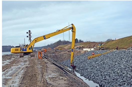
*In Bauzone A werden aktuell der Fußgraben und das neue Deckwerk erstellt.*
