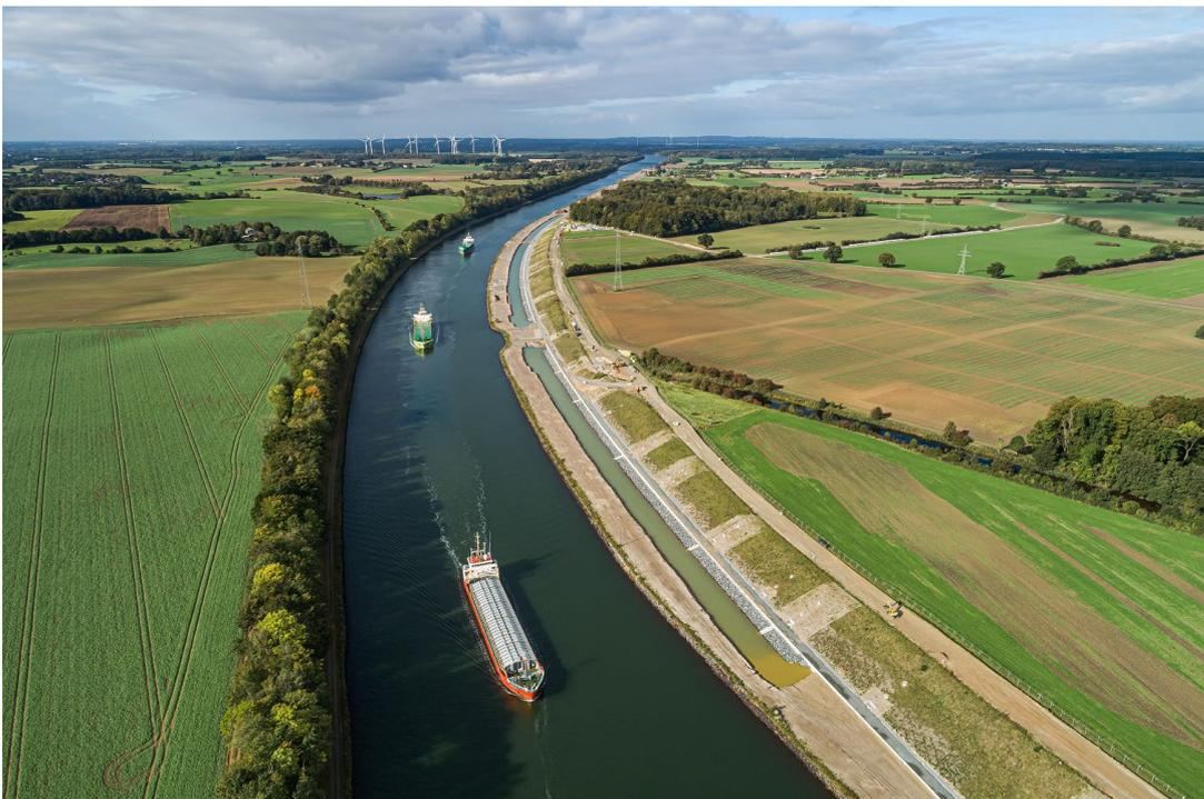
*Das neue Deckwerk ist im größten Teil des ersten Ausbauabschnitts fertiggestellt und der Fußgraben in diesen Abschnitten schon geflutet (Stand: Oktober 2023).*
