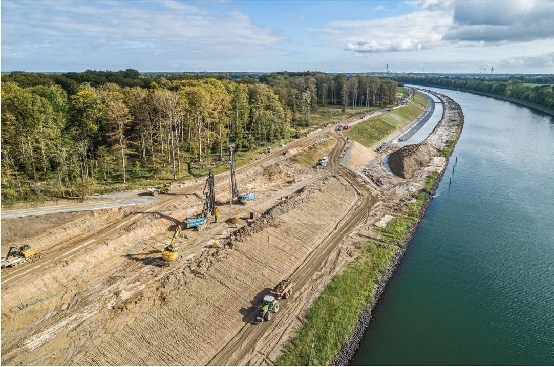
*Sobald die Sanierungsarbeiten der Bodenrutschung in der Bauzone D abgeschlossen sind, beginnen auch dort die Arbeiten am Betriebsweg, Fußgraben und Deckwerk (Stand: Oktober 2023).*
