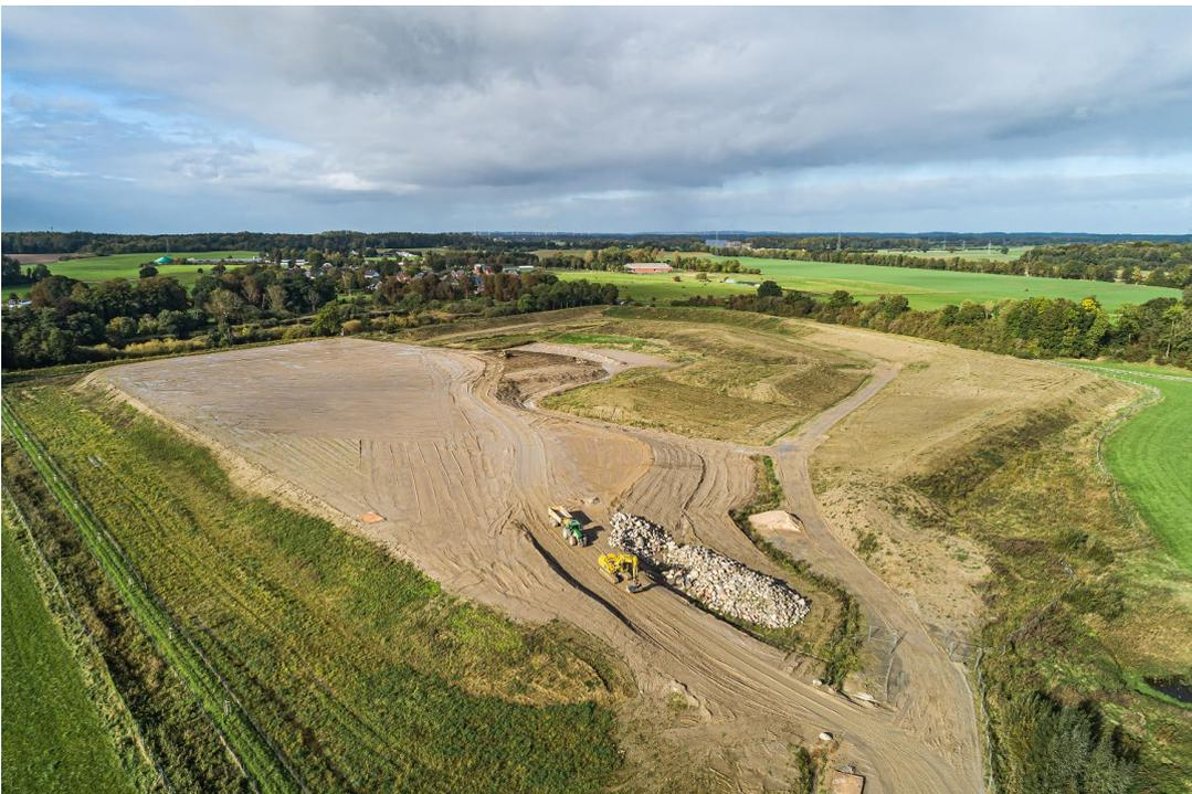
*Der ausgehobene Boden wird in das temporäre Bodenlager in Flemhude eingebaut.*
