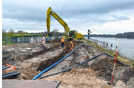
*Neue Rampe zum Betriebsweg und Verlegen von Leitungen im Bereich der Rosenkrantzer Au*
