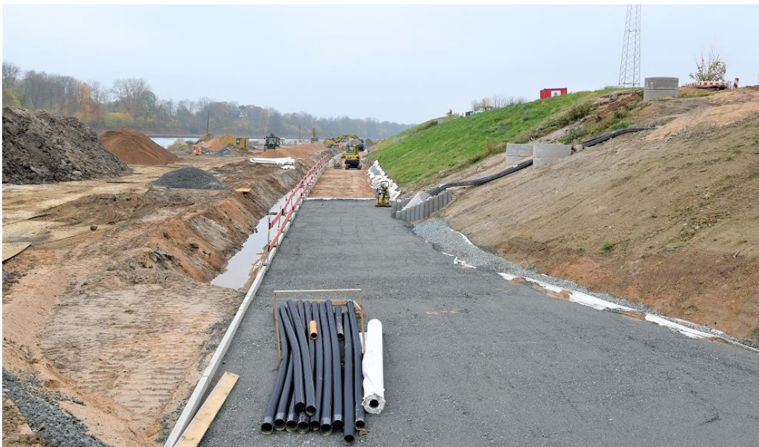
Neuer Betriebsweg und begonnener Aushub des Fußgrabens
