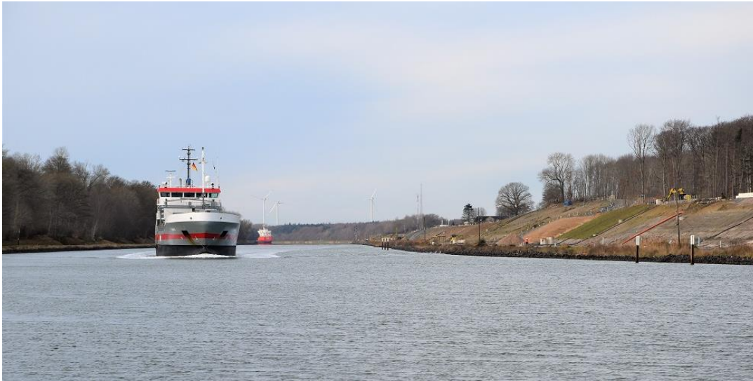
Blick in Richtung Westen auf die neue Überwasser-Böschung
