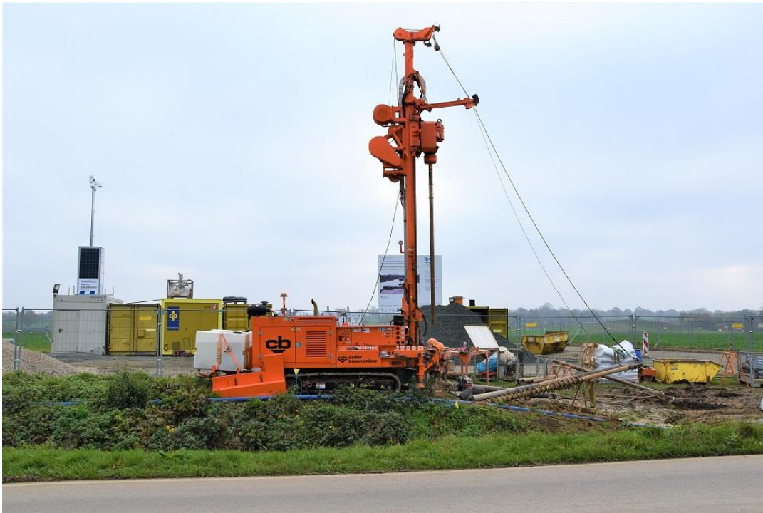
Vertiefende Baugrunduntersuchungen im Bereich der Baustraße für den zweiten Bauabschnitt
