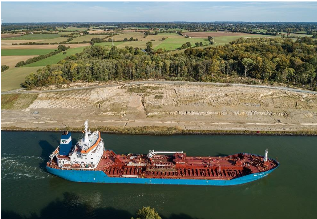
Bodenrutschung im Bereich des kleinen Waldgebiets
