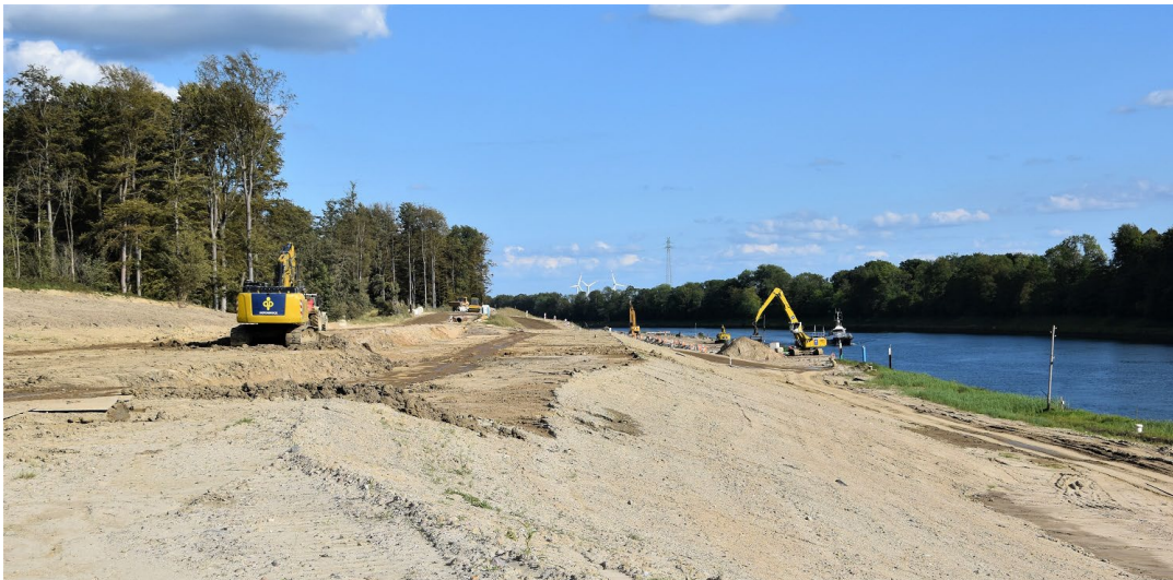
Erstellen einer neuen Arbeitsebene für die nächste Lage von Drainagesäulen
