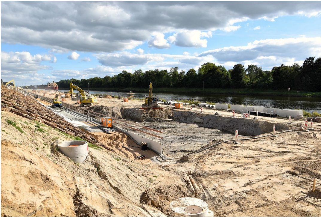
Beginn der Arbeiten am Fußgraben in der Bauzone A
