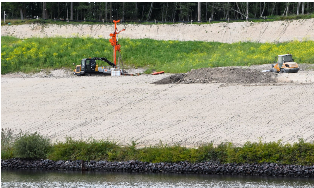
Einbau einer Grundwassermessstelle für das Monitoring
