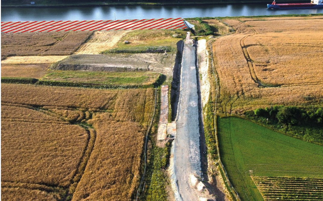
Ablagerungsfläche Warleberg Süd mit Baustraße. Am Ufer des Nord-Ostsee-Kanals ist, rot schraffiert, der Standort des zukünftigen temporären Schiffsanlegers eingezeichnet.
