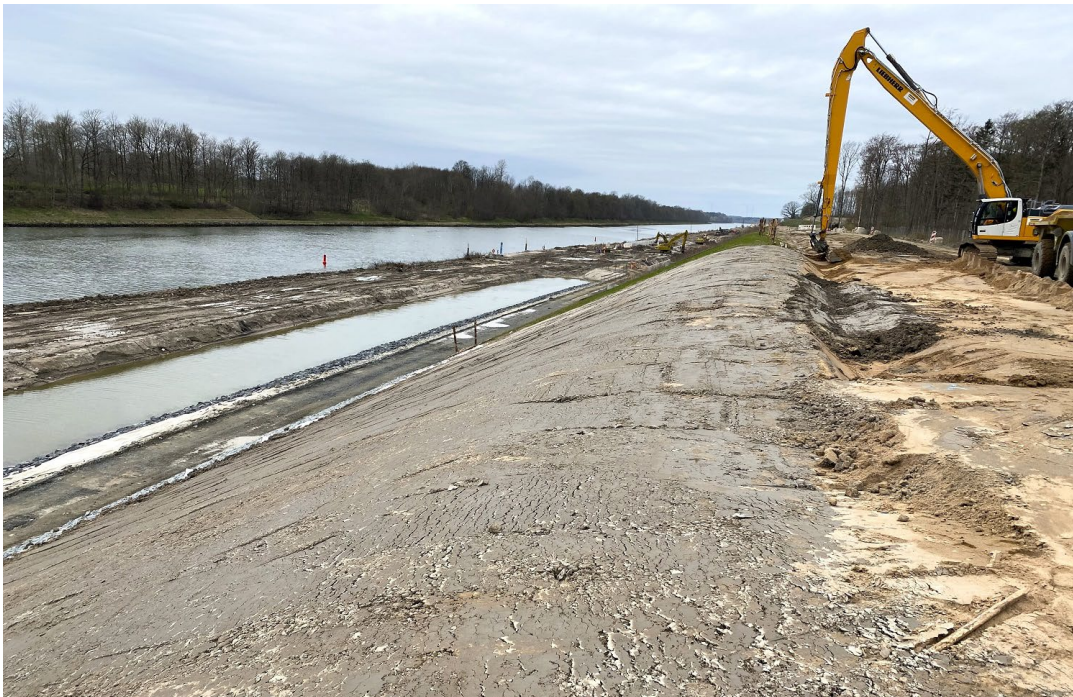
Die Sanierung der kleinräumigen zweiten Böschungsrutschung in Bauzone D ist abgeschlossen (Stand: April 2024).
