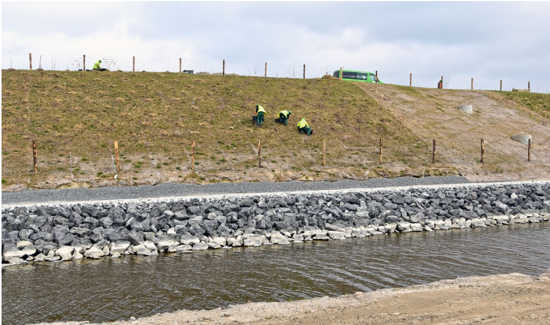
An der neuen Böschung werden Sträucher und Baumsetzlinge gepflanzt (Stand: März 2024).
