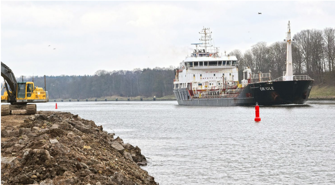
Rote Tonnen zeigen die verengte Schifffahrtsführung im Bereich des ersten Bauabschnitts an (Stand: März 2024).
