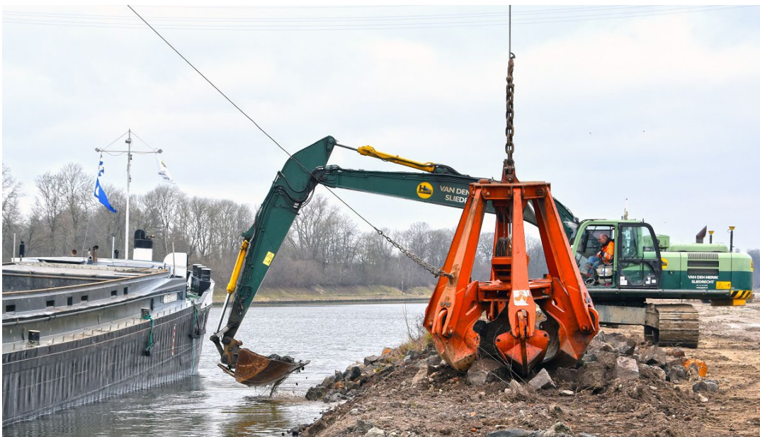
In einem ersten Schritt wird das alte Deckwerk entfernt (Stand: März 2024).
