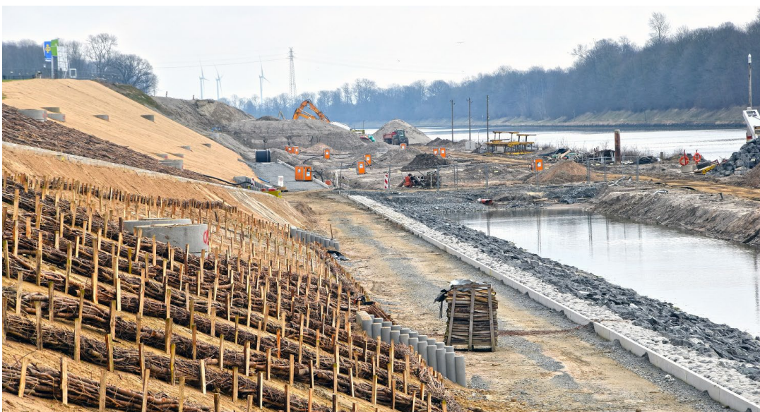
Die neue Böschung wird mit Kokosmatten und Faschinen gesichert. Im Hintergrund ist der letzte Bereich zu sehen, in dem die neue Böschung noch erstellt werden muss (Wendehammer Großkönigsförde, Stand: März 2024).
