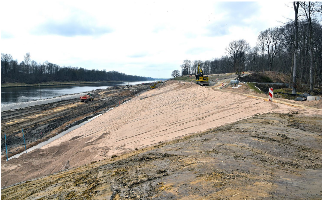
Sanierte Bodenrutschung in der Bauzone D (Stand: März 2024)
