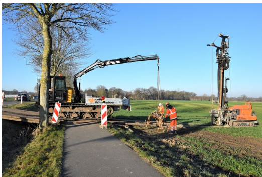
Vertiefende Baugrunduntersuchungen im Bereich der Verbringungsfläche Warleberg Zentral und an der Fähre Landwehr
