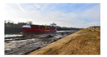
Um die Passagezeiten im Nord-Ostsee-Kanal für die Schifffahrt verlässlich zu gestalten und ihn auf die Schiffsverkehre der Zukunft vorzubereiten, baut die Wasserstraßen- und Schifffahrtsverwaltung des Bundes die Oststrecke zwischen Großkönigsförde und Holtenau in mehreren Bereichen aus. Vorgesehen sind die Verbreiterung des Kanals auf eine Mindestsohlbreite von 70 Metern und die Vergrößerung der Radien enger Kurven, damit die Schifffahrt diese leichter passieren kann.
