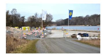
Im Zuge der vorbereitenden Maßnahmen wurde am Flemhuder See eine Baustelleneinrichtungsfläche mit Bauhafen und Betriebsstraße angelegt. Die Baustelleneinrichtungsfläche ist eine notwendige Voraussetzung für den Ausbau der gesamten Oststrecke. Sie wird als Zwischenlager und zum Ausschleusen von Böden benötigt, die nicht auf landwirtschaftlichen Flächen abgelagert werden können. Darüber hinaus wird die Fläche am Flemhuder See als Lager für Baustoffe, wie zum Beispiel Wasserbausteine, genutzt.
