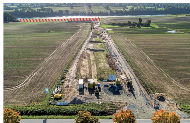
Neue Baustraße zwischen Kreisstraße 90 und der Ablagerungsfläche Warleberg Süd. Im Hintergrund ist, rot schraffiert, der Standort des zukünftigen temporären Schiffsanlegers eingezeichnet.
