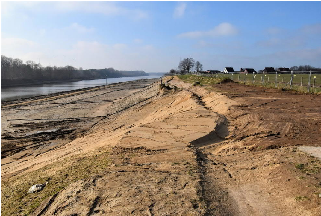
Reparierter Erosionsschaden in Bauzone A
