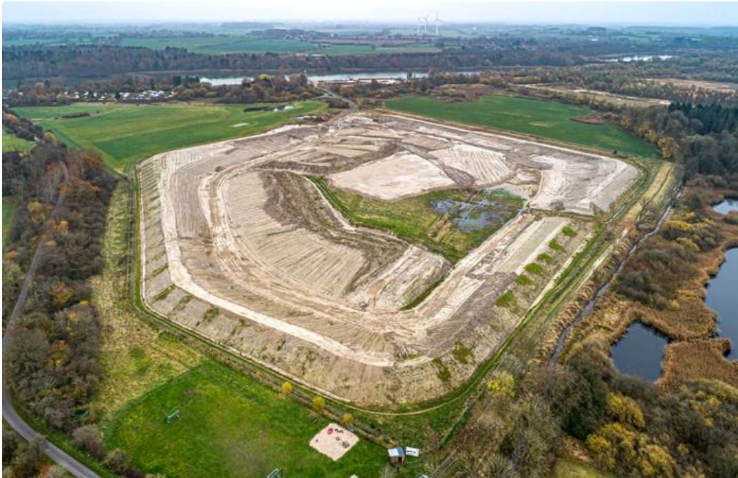
Fertiger Schutzdamm rund um die Baustelleneinrichtungsfläche Flemhude
