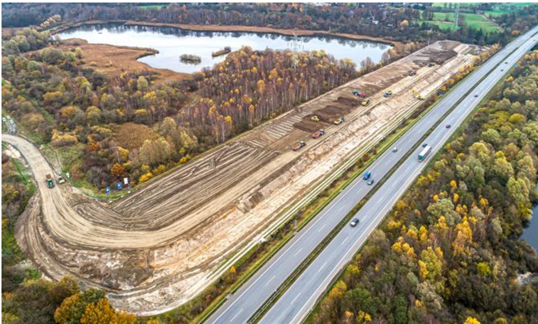
Bodeneinbau am Erdwall an der Autobahn 210
