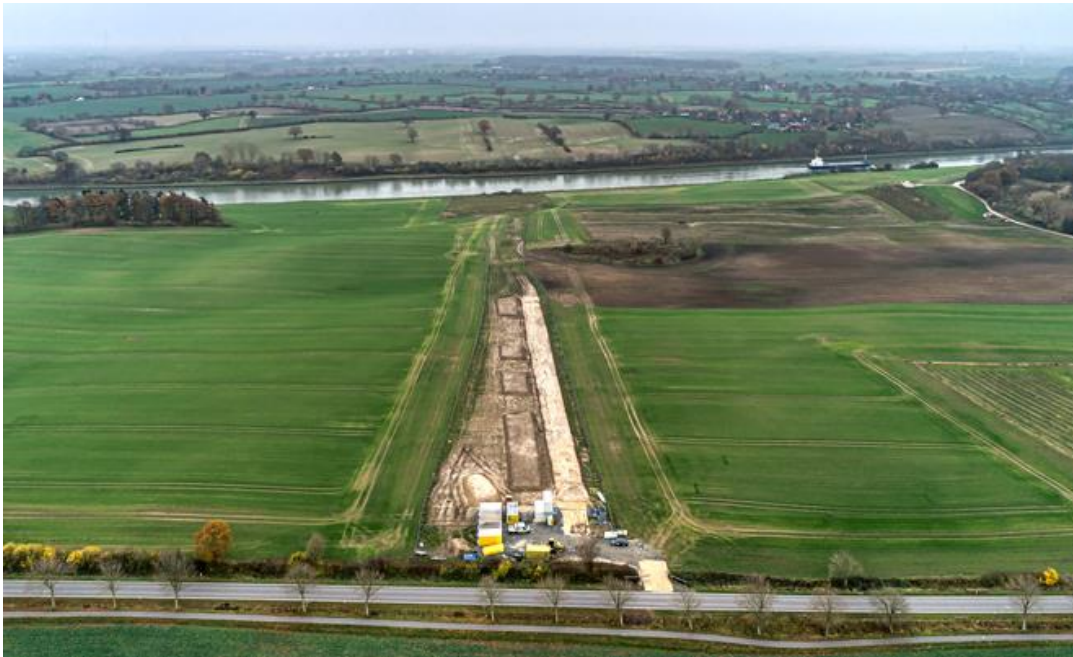
Baustelleneinrichtung der Ablagerungsfläche Warleberg Süd
