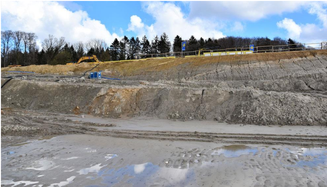
Bodenabtrag bis auf die Höhe des Wasserspiegels des Nord-Ostsee-Kanals
