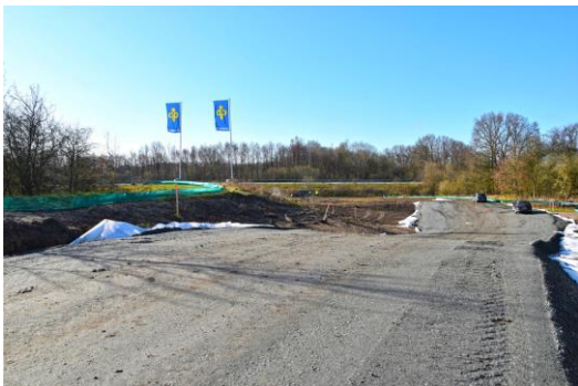
Neue Baustraße für den Erdwall an der Autobahn 210 mit Zäunen zum Amphibienschutz
