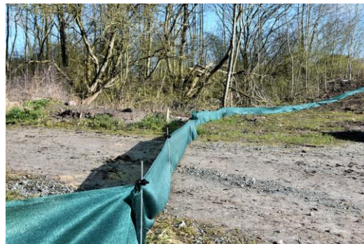
Neue Baustraße für den Erdwall an der Autobahn 210 mit Zäunen zum Amphibienschutz
