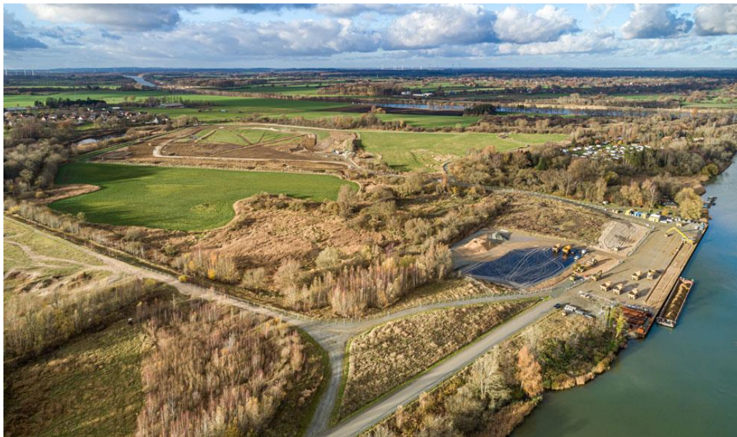
Baustelleneinrichtungs- und Bodenlagerfläche Flemhude (Blick Richtung Nordwest)
