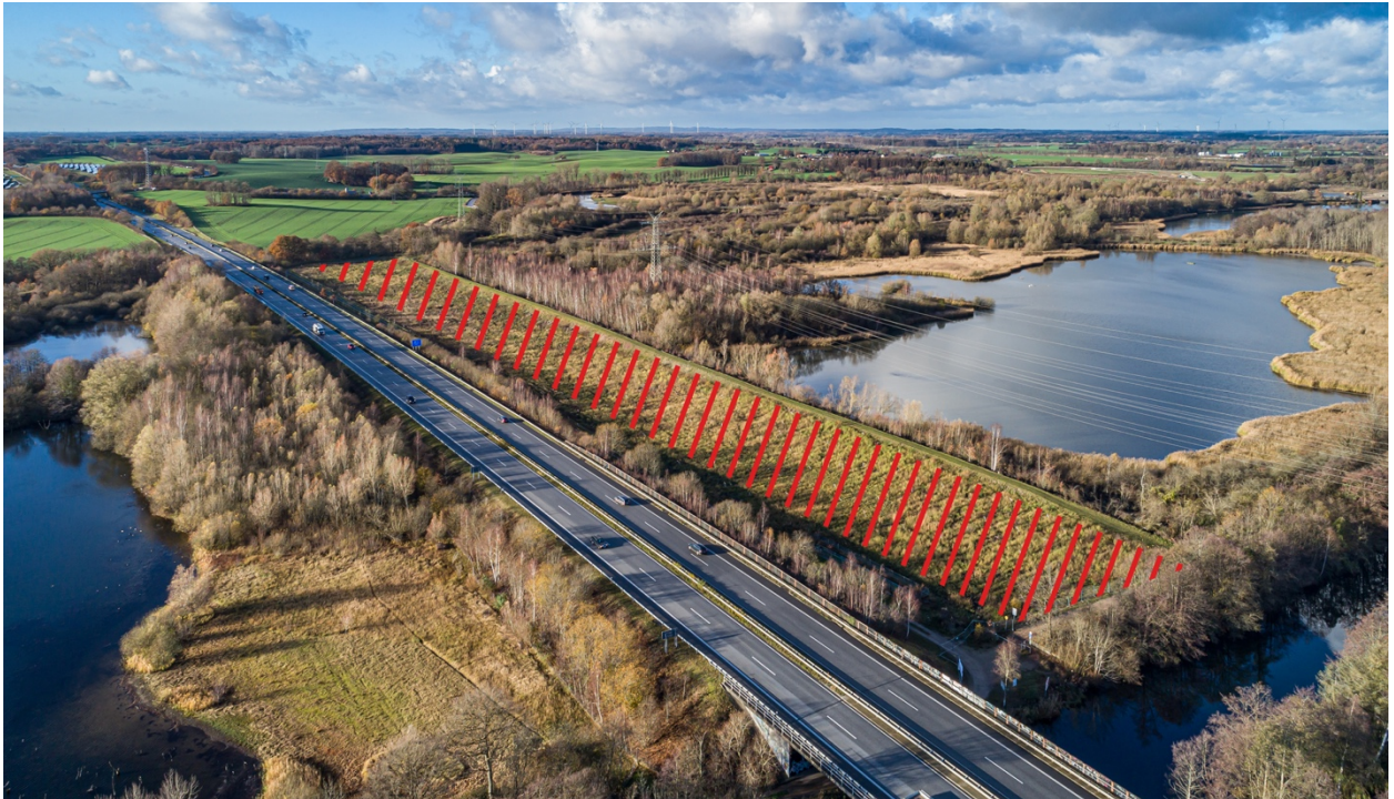
Standort des zukünftigen Erdwalls an der Autobahn 210
