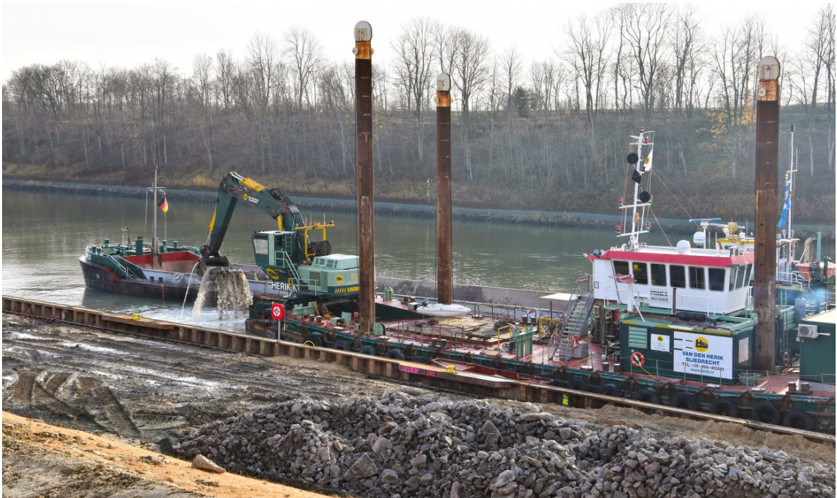
Nassbaggerarbeiten an der temporären Anlegestelle
