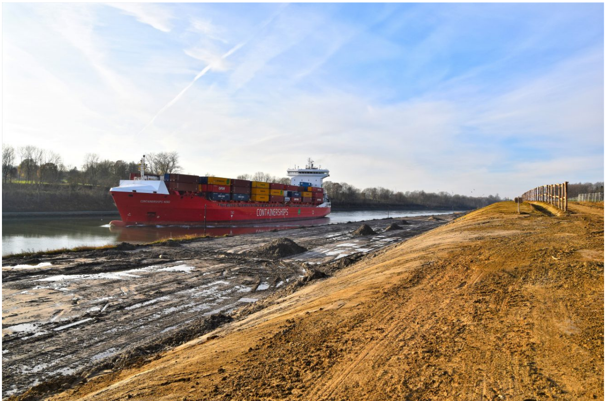
Bodenabtrag bis auf die Höhe des Wasserspiegels des Nord-Ostsee-Kanals
