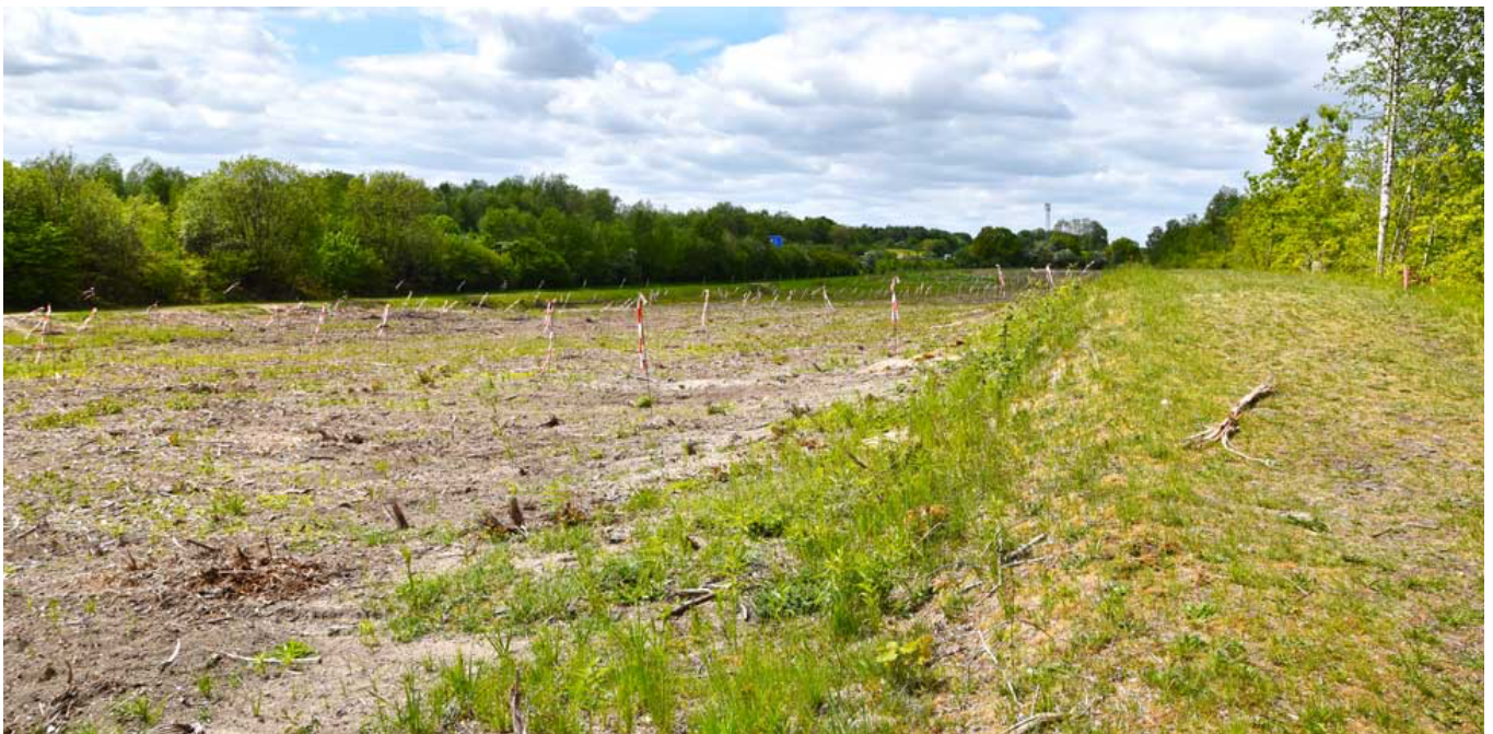
Standort des zukünftigen Erdwalls an der Autobahn 210
