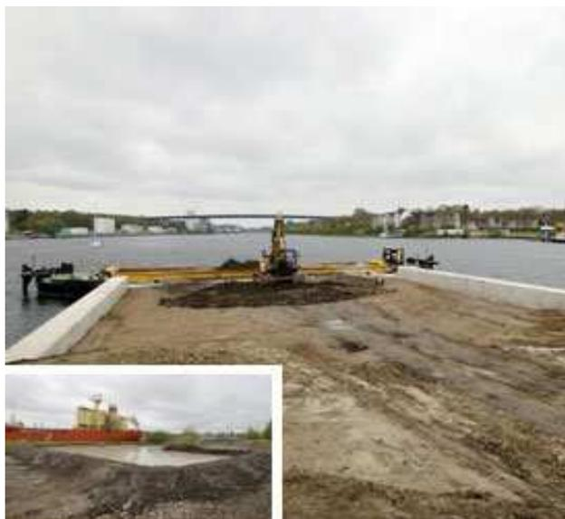
wurden temporär zwei Absetzbecken für Stützflüssigkeit der Schächte errichtet.
