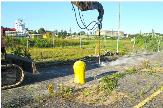
Bohrlochsondierung an Land
