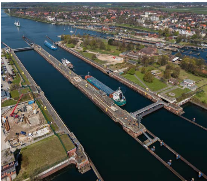
Nach über 100 Jahren Betrieb muss die Schleusenanlage Kiel saniert werden.
