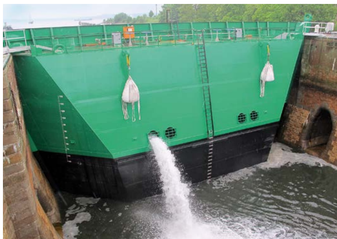
Die bestehenden Sperrtore können auch für die neue Kleine Schleuse genutzt werden.
